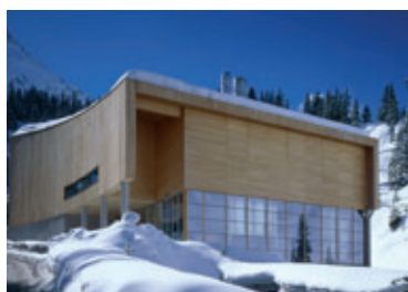
Heizwerk in Lech
