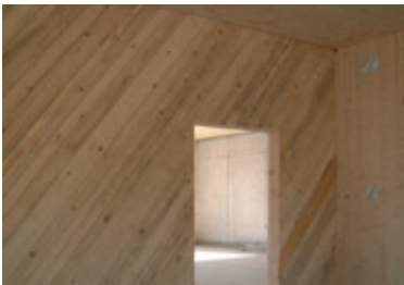
Einsatz von heimischem Vollholz und eine Holzdiagonalschalung mit sägerauen Brettern statt OSB Platten.
